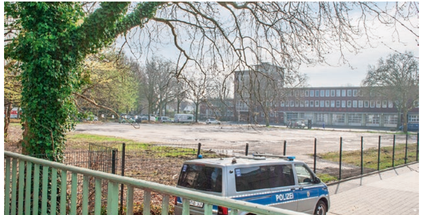
Neben der Polizeiwache entsteht die Grundschule auf dem Wildenbruchplatz
