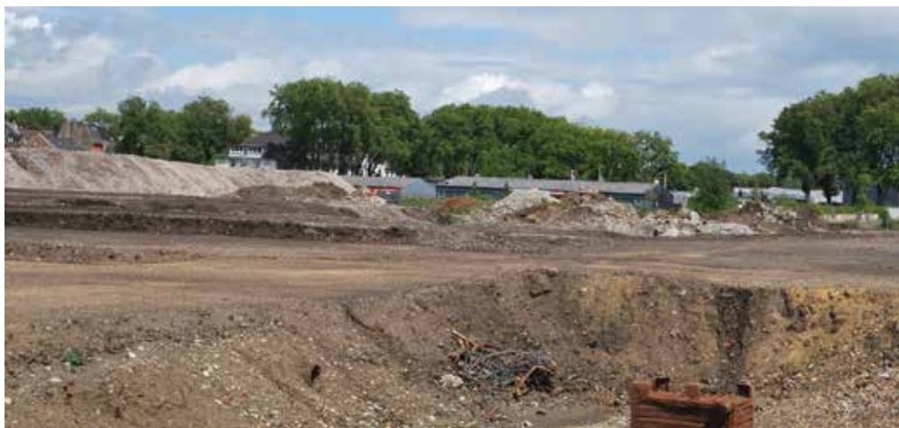
Komplett frei geräumt: das ehemalige Exarchos-Gelände an der Kesselstraße in Bulmke
