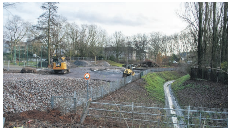
Große Baustelle für die Renaturierung des Sellmannsbachs zwischen der Florastraße und der Bulmker Straße, rechts der noch eingezwängte Bach
